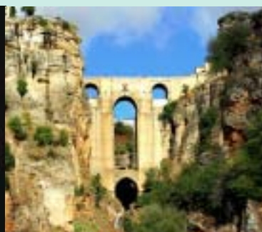
Puente Nuevo, Ronda
