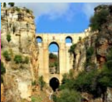
Puente Nuevo, Ronda
